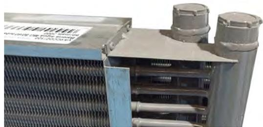
En cas de fuite, vérifier si cela vient d'un problème de corrosion et vérifier si d'autres composants sont touchés.
