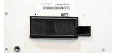
Pour les modèles électriques 30 kW, le bornier noir est remplacé par une plaque pré percée et le rideau d'air est fourni avec un presse-étoupe pour la pénétration du câble d'alimentation dans le rideau d'air afin de le raccorder au terminal dédié.
