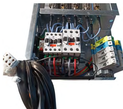
Type de raccordement pour les modèles G-ECG taille 2000/2500/3000 (avec 2 contacteurs)
