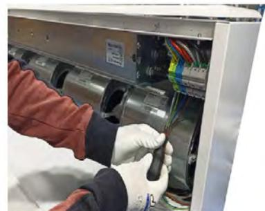
Pour les batteries électriques de 30 kW avec contacteurs, déconnecter l'alimentation électrique de la batterie électrique depuis l'intérieure du rideau d'air chaud
