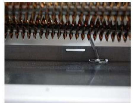
Modèles électriques : Déconnecter l'alimentation électrique au niveau de la batterie électrique
