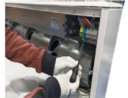
Pour les modèles avec contacteurs, retirer les connexions électriques à l'intérieur du rideau d'air
