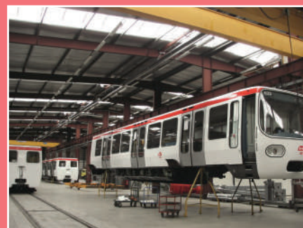
Ateliers de maintenance
