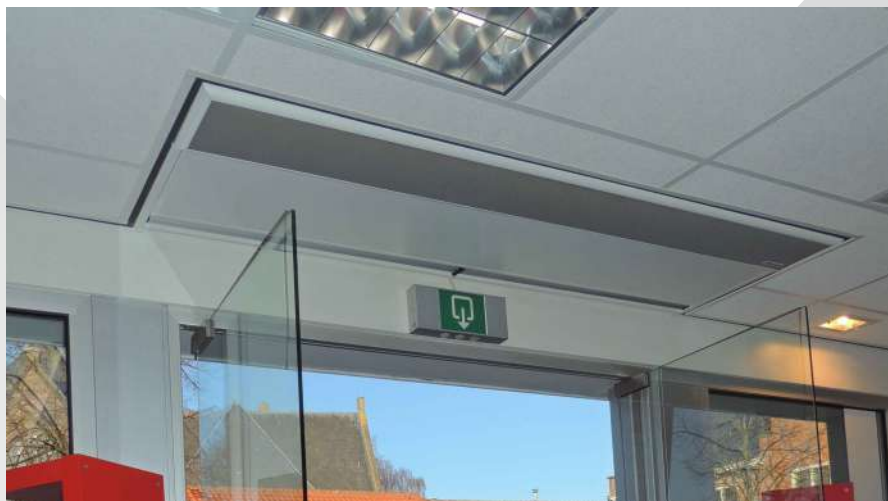
Montage encastré arasant en faux-plafond avec plénum
