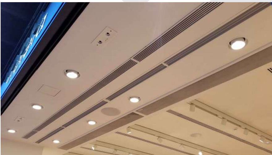
Montage encastré invisible en faux-plafond avec plénum et kits télescopiques
