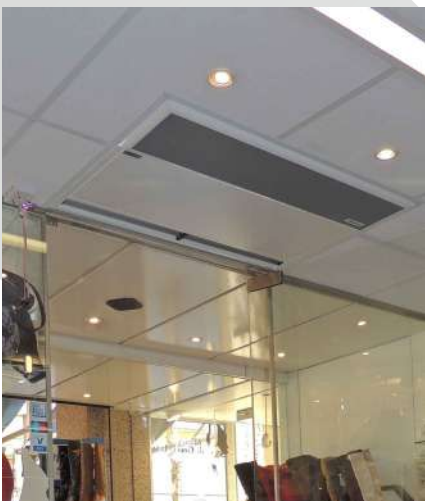
Montage encastré arasant en faux-plafond avec plénum
