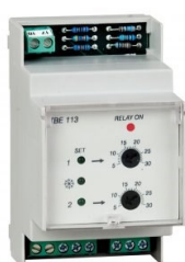
OP-EXR3 Régulateur RAIL DIN 3 points de consigne (jour / nuit / hors gel) à coupler avec sonde résultante déportée (boule noire). Sonde non incluse.
