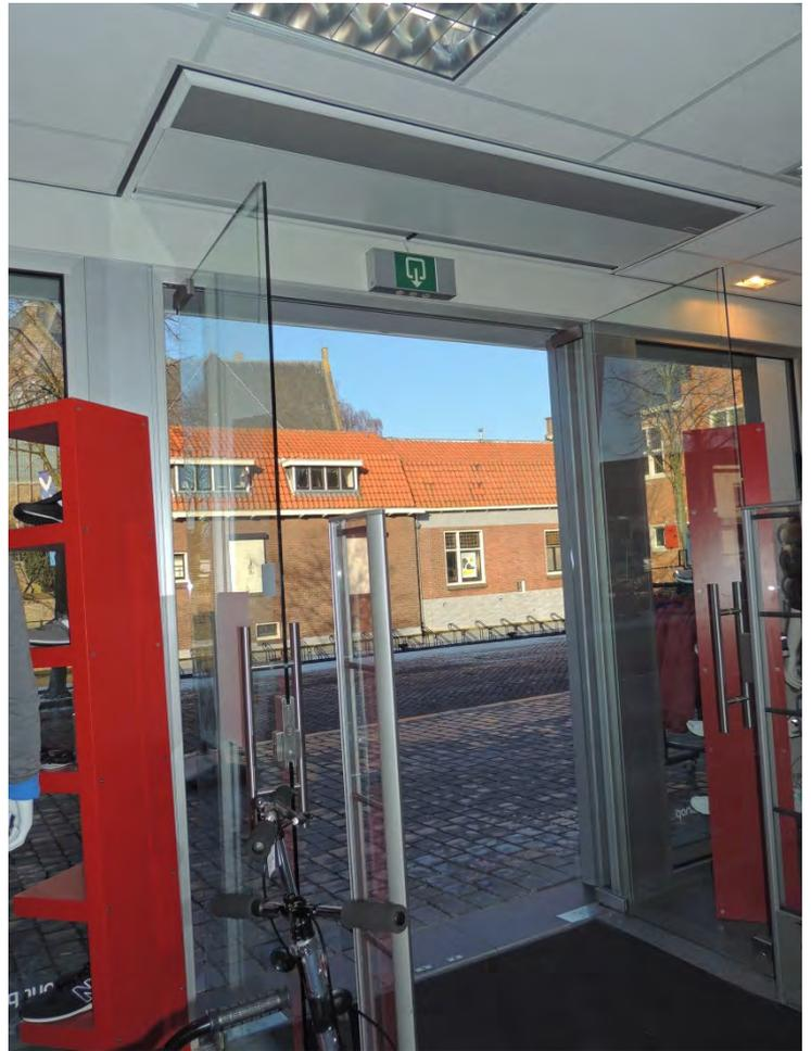
WINDBOX AVEC PLENUM MONTAGE INVISIBLE
