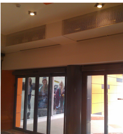
Windbox Montage multiple en suspension libre
