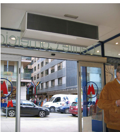
Duojet Basse consommation, air chaud est diffusé côté intérieur du local
