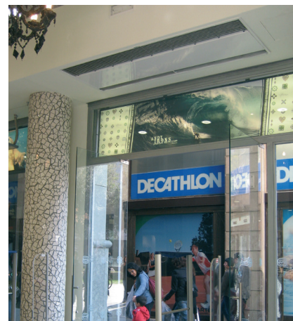
Windbox Encastré Conçu pour être installé dans un faux-plafond
