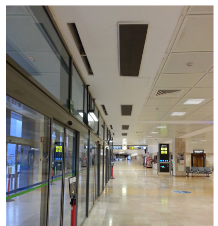
Windbox Montage multiple, invisible en faux-plafond
