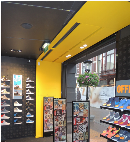
Dam Montage invisible en faux-plafond
