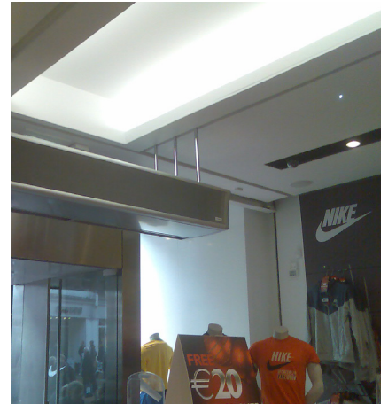
Deco Finition tout Inox, Montage en suspension libre
