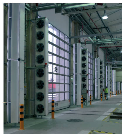
Max Tours multiples sur de larges portes industrielles
